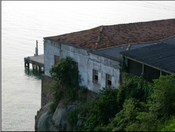
Figura 54 - Patrimônio arquitetônico - antiga salga (processamento de pescado).
